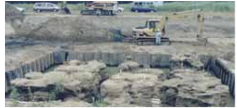
写真-1 開削状況
