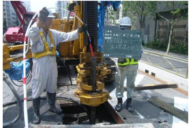
写真3 バイオチューブの埋設状況
