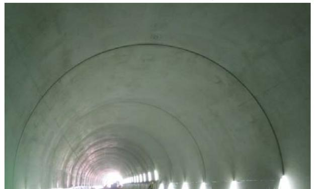
写真-2 中流動覆工コンクリートの外観
