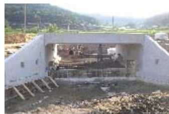
(c) 下部スラブ施工
