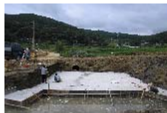
(a) 基礎片付け
