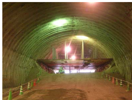
写真-1 トンネル坑内切梁補強
