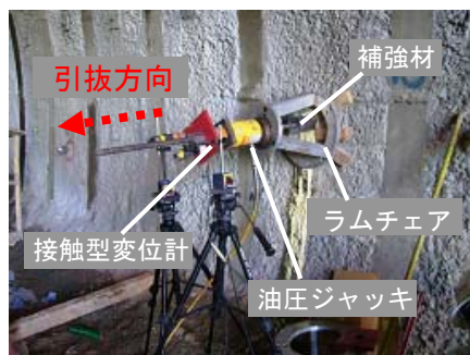
写真-2 現場引抜試験状況
