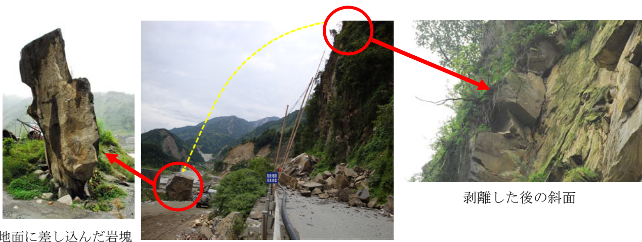
写真—1 映秀鎮の断層周辺の飛び出し崩壊
