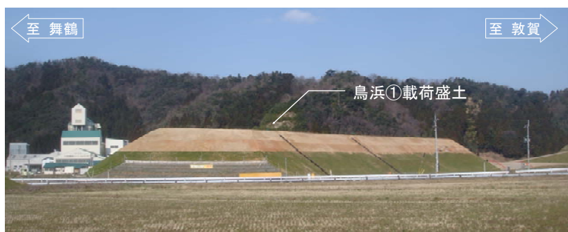
写真-1 向笠地区における鳥浜①载荷盛土
