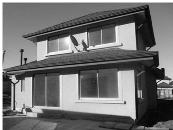
写真 2 軟弱地盤上の埋土の液状化による建物の沈下
