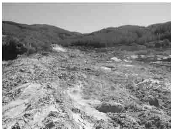
写真 1 Las Palmas の鉱さいの液状化による堆積場の崩壊
