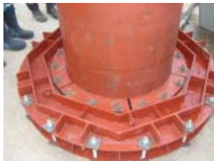
写真2 接合部構造（接合時）
