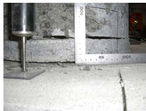
写真 - 2 PC 鋼棒拔出し状況
