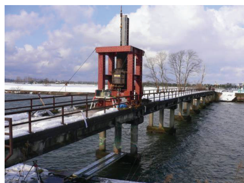
写真 試験橋脚と試験装置
