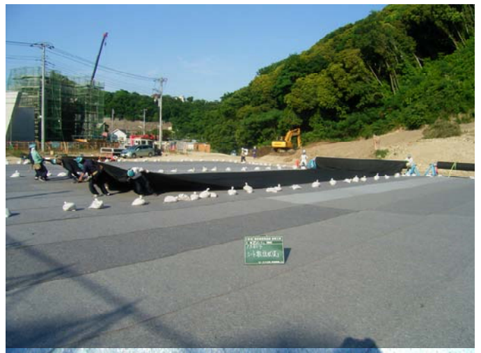
写真-1 遮水シート敷設状況
