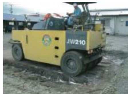
写真-2 施工状況
