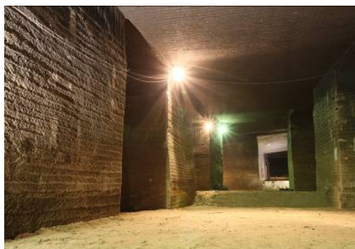
写真-1 地下空間内部の状況
