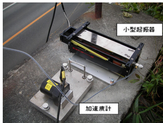
図2 土留め壁天端における設置状況
