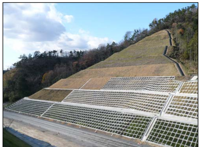
写真2 トップリング発生のり面の対策後全景
