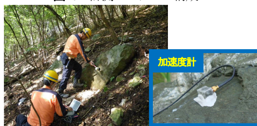
写真-1 計測状況
