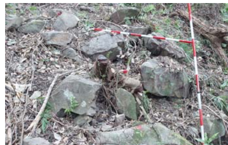
写真-1 下部斜面の転石状況
