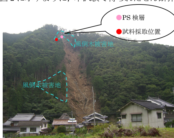
図 1 崩壊地の状況
