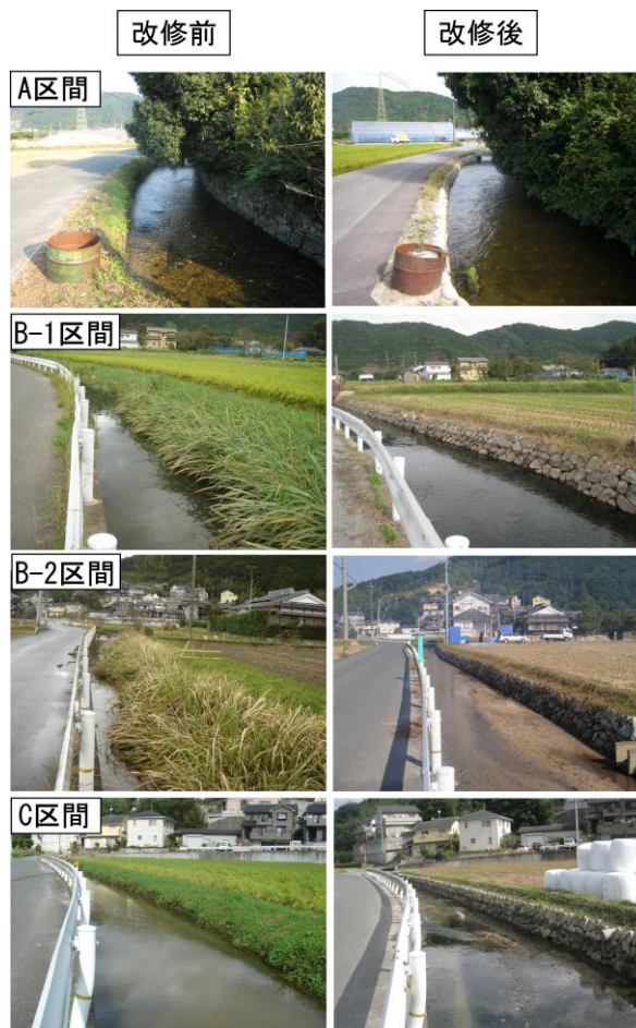
図 1 各区間の改修前後の様子
