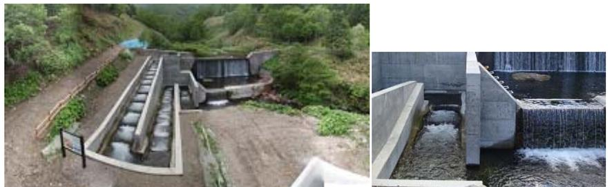
写真4 施工された提案魚道の全体像と魚道下流端の状態
