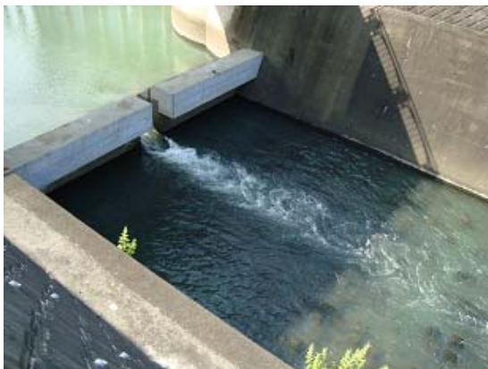
写真1 本川に設置されている洪水調節堰
