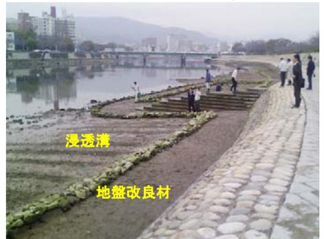
図3 旧太田川空鞆橋下流ヘドロ上に施工された遊歩道、前面は浸透溝(浸透柱の改良型)河岸に堆積したヘドロ干潟上に地盤改良材(主材料は堆積ヘドロと産業廃棄物である石炭灰)を用いて施工(太田川河川事務所施工)、干潟上が歩行可能になりカニ穴も遊歩道内に掘られている。
