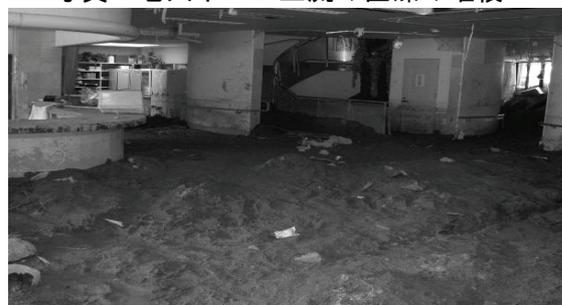
写真2 老人ホーム内部の土砂堆積
