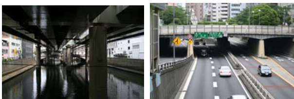
写真-1 日本橋川および楓川を占有した首都高速道路（左：日本橋川、右：楓川）
