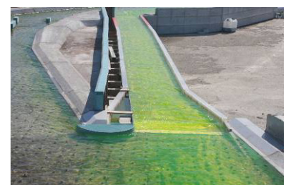
写真-3 分水路呑口部の流況
