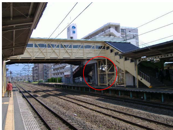
写真-1 検討対象古レール造乗換え跨線橋
