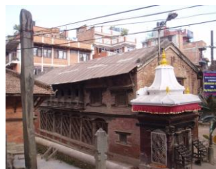
図2 対象建物外観
