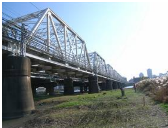
図－1 試験施工対象橋梁
