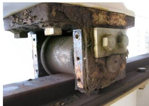
図-1 可動支承の腐食例
