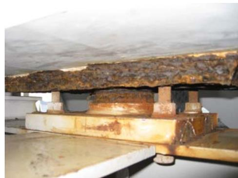
図-3 固定支承の腐食例
