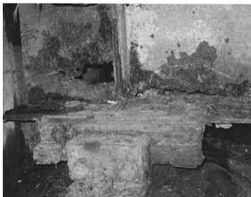
図1 端部局部腐食の事例
