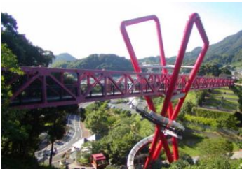
図 6 中尾城公園歩道橋
