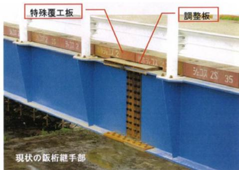
写真-1 従来の仮設鋼桁の連結構造
