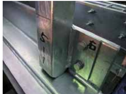
写真-4 試験体④（溶接固定）
