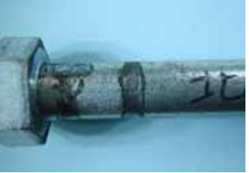
図-6 ボルト胴回り
