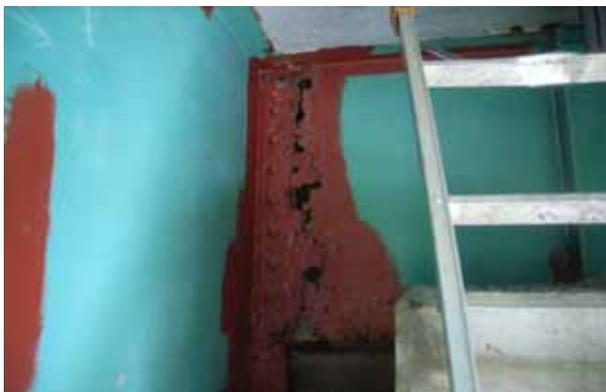
写真-2 端横桁腐食状況
