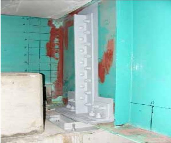
写真-3 仮支点補剛材施工状況
