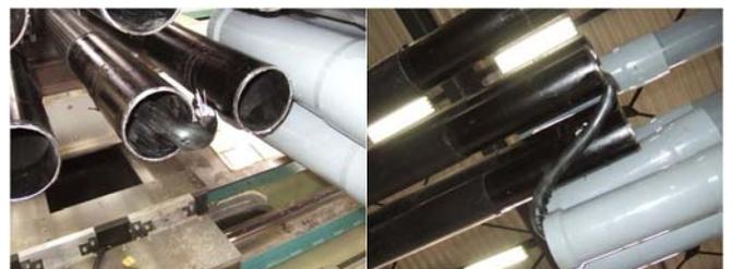
図9 現仕様継手の離脱・ケーブル損傷
