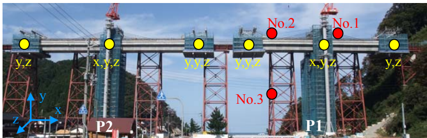
図 1. 風速と加速度応答の計測位置
