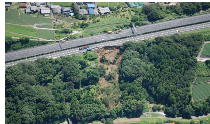
写真-1 盛土崩落状況(国際航業(株)提供)
