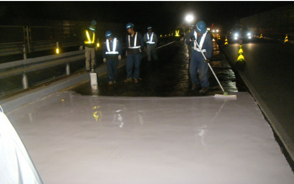
写真－3 防水工実施工状況
