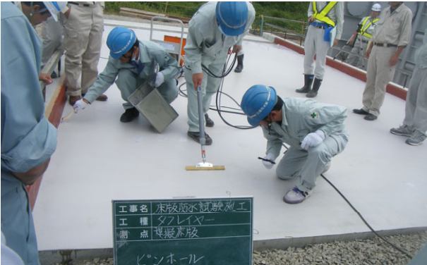
写真－2 試験施工でのピンホール検査状況
