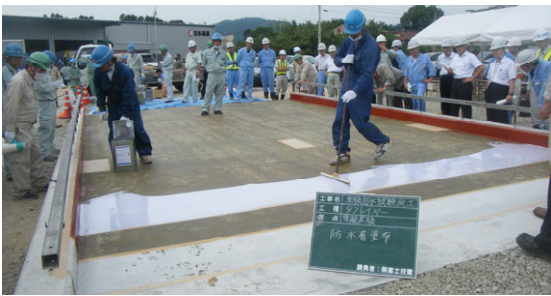
写真-1 模擬床版による防水工試験施工状況
