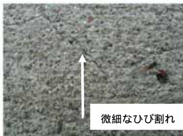
写真3 微細なひび割れ
