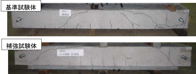
図-2 静的載荷試験後の試験体
