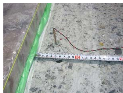
写真1 モールドゲージ設置状況
