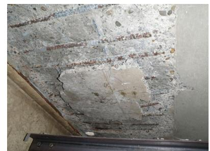
写真-1 剥離破壊部撤去後の状況
