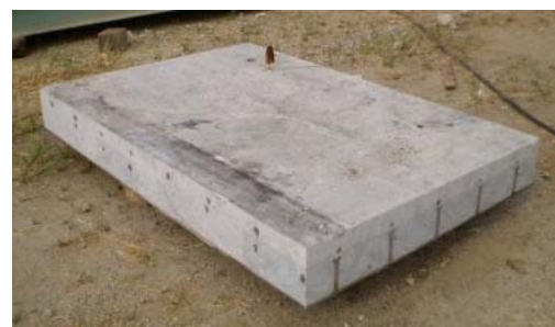
写真-1 切断状況
