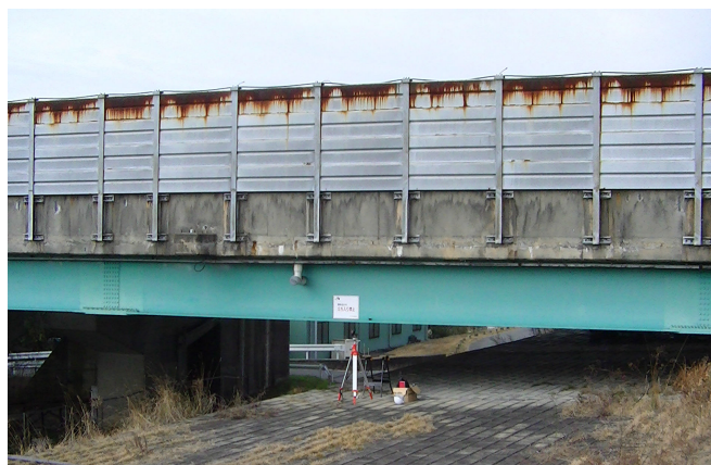
写真-1 小島高架橋
