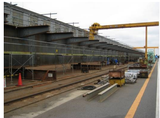
図1 御殿場高架橋
