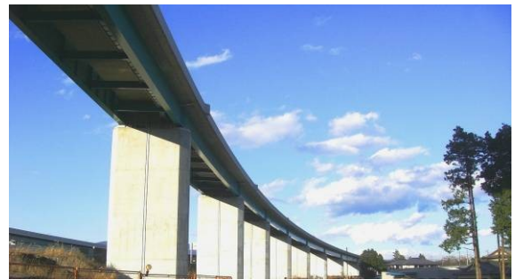
図 3 御殿場ジャンクション C ランプ橋
