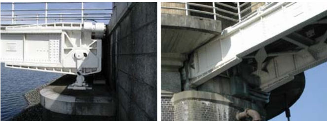
写真 1 ケーブル定着部 写真 2 定着部と取水塔
