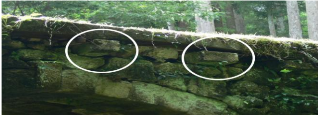
図-3 貫石部分(東口橋)
