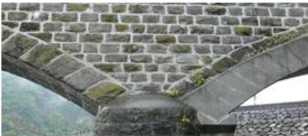
図-4 耶馬溪橋の壁石（大分県中津市）
