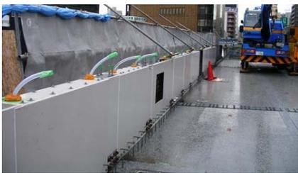
写真-5 型枠鋼板設置
