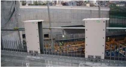
写真-3 ビルトH鋼設置
