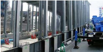
写真-4 遮音壁支柱設置
